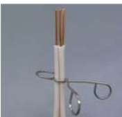
被覆の端を揃えることで、 リングスリーブ圧着がきれいに仕上がります。
